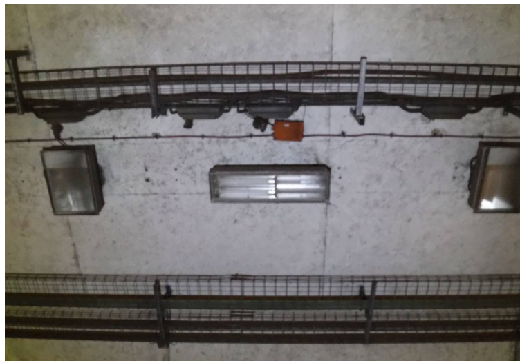
Luminaires et chemins de câbles à déposer pour pose des plaques
